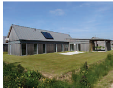
Maison de gabarit traditionnel avec annexe et auvent accolés, archi. COBE
