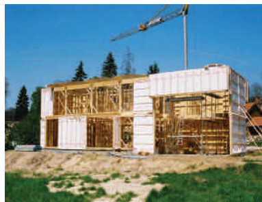
Chantier d'une maison à ossature bois
