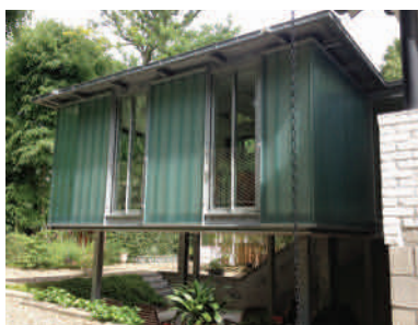
Extension contemporaine d'une maison années 60, créant une pièce lumineuse, archi. Arnaud Coutine
