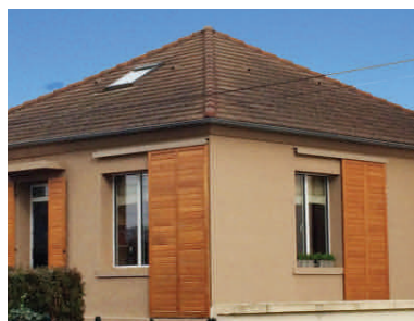
Maison des années 60 réhabilitée avec un enduit de teinte soutenue, de nouvelles menuiseries et des volets en bois coulissants
