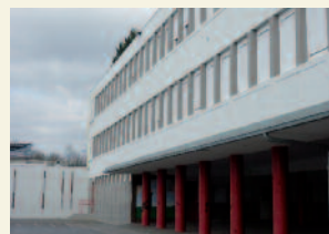
Le collège Sonia Delaunay retenu pour l'implantation du Noeud de Raccordement Optique principal
