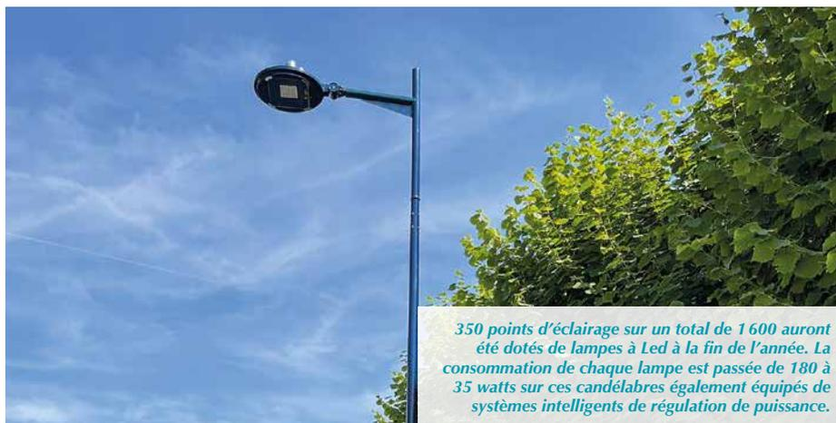
350 points d'éclairage sur un total de 1600 auront été dotés de lampes à Led à la fin de l'année. La consommation de chaque lampe est passée de 180 à 35 watts sur ces candélabres également équipés de systèmes intelligents de régulation de puissance.
